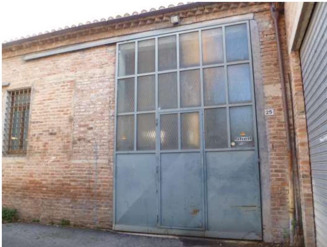
Deposito mezzi comunali – Via Campo fiera nn.23-25
