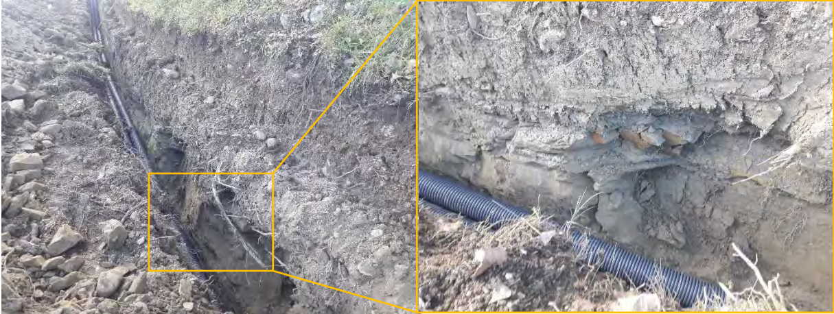
Figura 11: substrato geologico rinvenuto in una trincea eseguita lungo la strada provinciale
